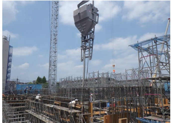
電動式コンクリートバケットによるコンクリート打設
