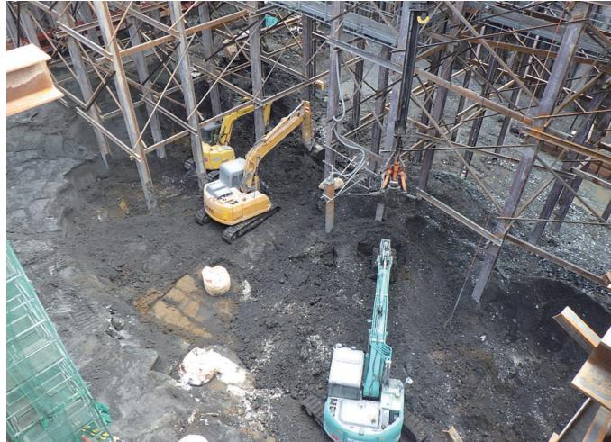
機械土工事では、様々な大型重機を操り建物の地盤を形成します。工事着工前に現場の仮設状況や地盤調査・周囲の環境を考慮した重機の選定など、綿密な打合せを重ねた計画を基に、現場工程に添った施工を実施します。
